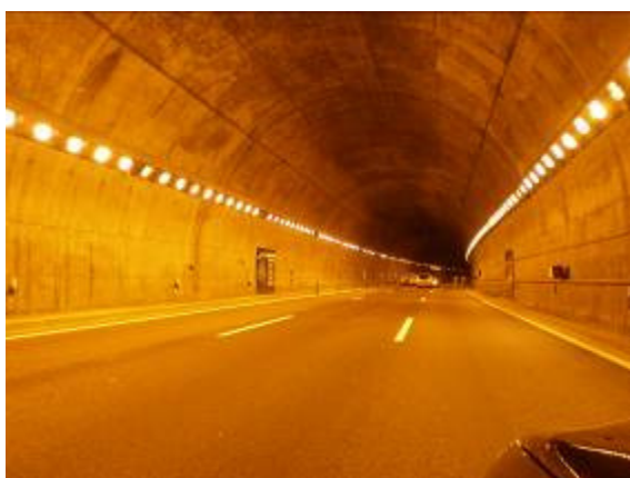
Túnel de Somosierra (Autovía A-1) Calzada izquierda Sentido descendente
