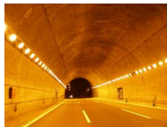
Túnel de Somosierra (Autovía A-1) Boca norte, Calzada izquierda Sentido ascendente
