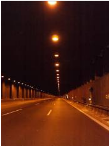
Túnel M-40 VSAP
